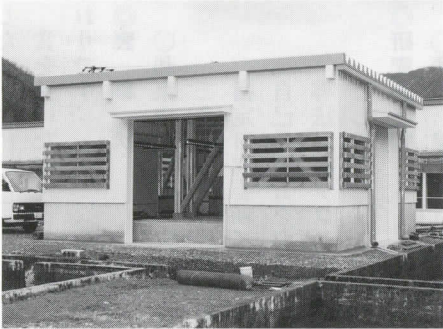
▶完成したふ化水槽（建物）
